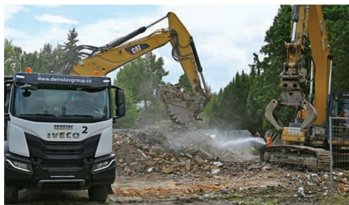
Bývalá ubytovna Vrchlického se v srpnu změnila v hromadu sutin, kterou stroje usilovně rozebíraly a odvážely. Zároveň se pracoviště kropilo, aby se v okolí příliš neprašilo. Foto: Petr Bakovský
