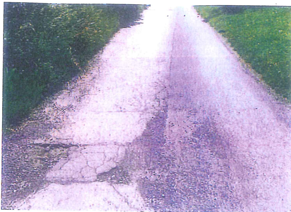
Obr. 36 Porucha celoplošného rozpadu – foto arch. objednatel posudku
