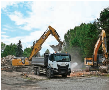
Jednou z nevyužitelných budov, které uvolnily místo zeleni, byla bývalá ubytovna v ulici Vrchlického. Foto: Petr Bakovský
