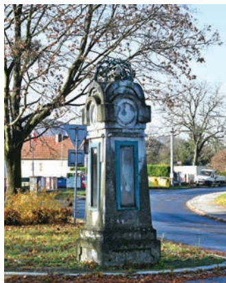
Neutěšený stav meteosloupu již dlouho volal po opravě. Foto: Petr Bakovský
