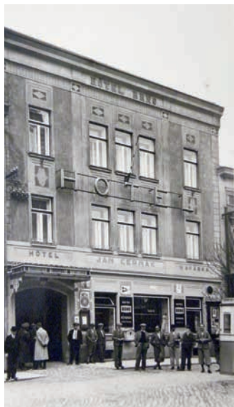
Budova hotelu Brno v roce 1934 za majitele Jana Čermáka.
