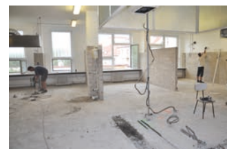
Rozvody vody a kanalizace se opravují postupně, takto se loni rekonstruovala kuchyň. Foto: Petr Bakovský
