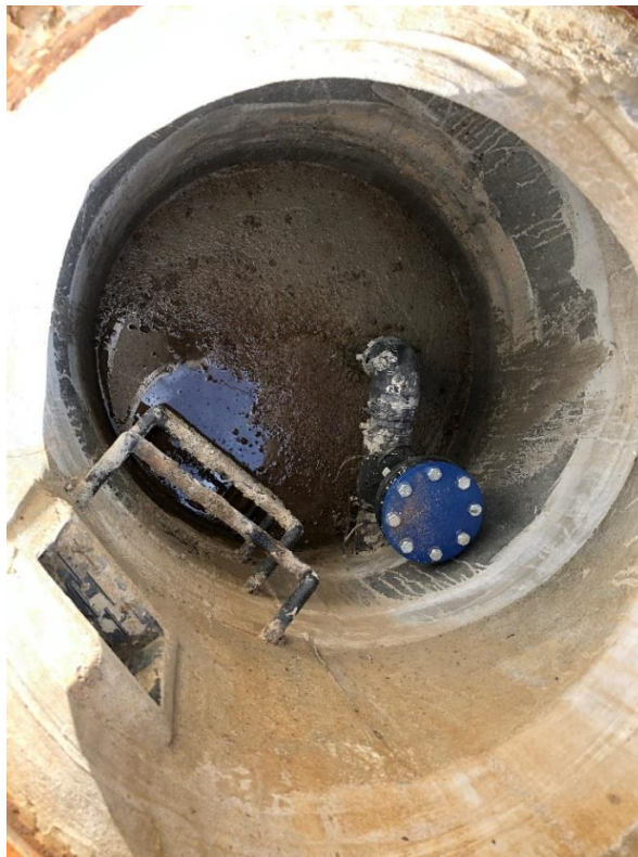
Obr. 4 – Vyústní šachta výtlač – zřejmě z důvodu přetrvávajícího zápachu zabetonována
